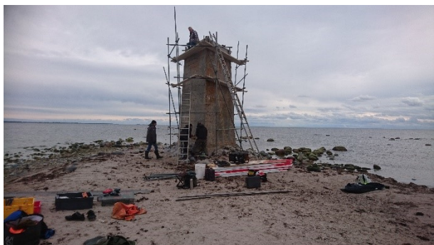
Byggnadsställningen rest på Austergrund
