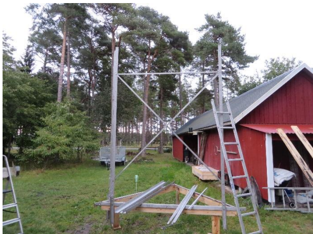
Hela stativet provmonterades i land
